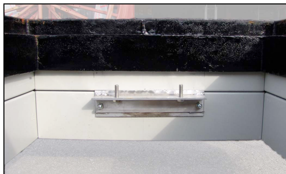
Förankring för låsbart innerlock monterat i en RaLaFlex-brunn.
